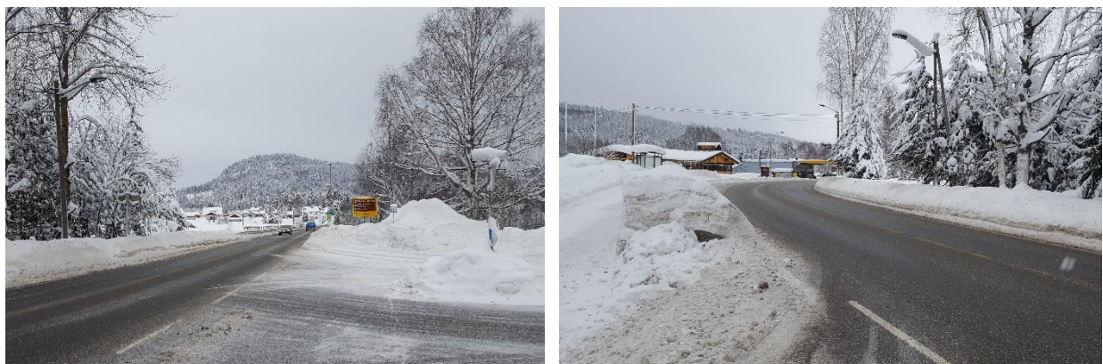
Figur 4: Siktforhold Østsideveien X E16. Befaringsfoto vinter 2018
